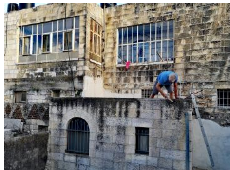
Renovierungsarbeiten am Haus
